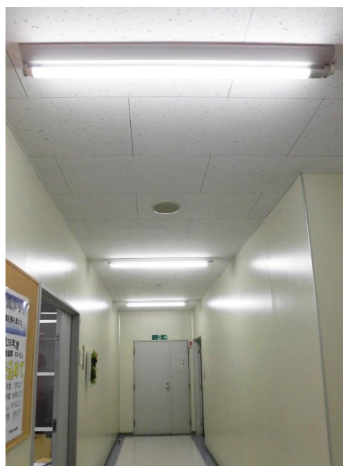
廊下の導入例（天井まで明るい）
