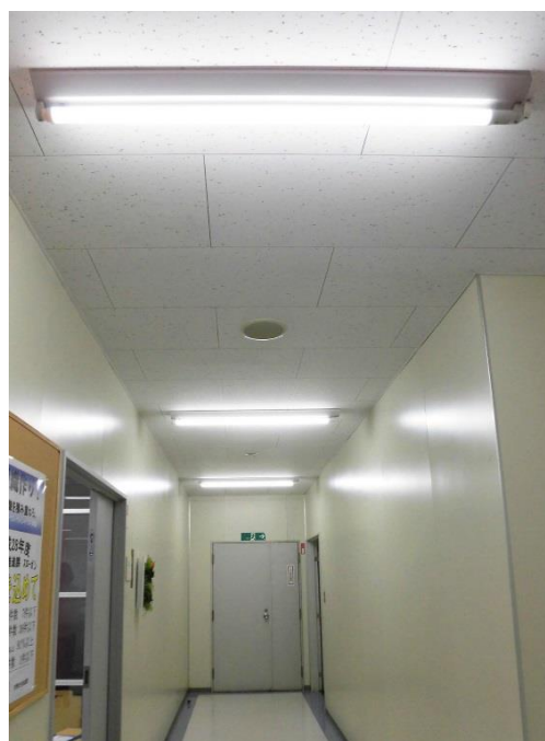
廊下の導入例（天井まで明るい）
